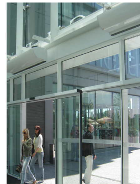
Cortinas de ar são fundamentais em entradas de estabelecimentos comerciais.
